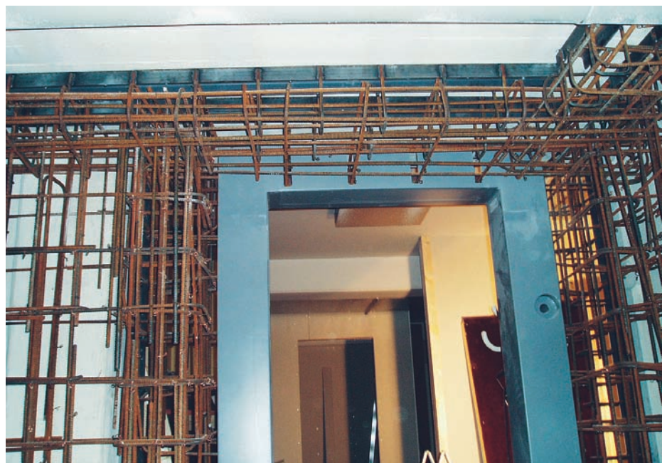
Bild 5. Det är fullt möjligt att på ett godtagat sätt ta upp en ny dörr i ett befintligt skyddsrum. Tekniska lösningar finns och en certifierad sakkunnig ska granska projektering och utförande.
